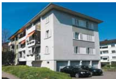
Mehrfamilienhaus in Bülach
